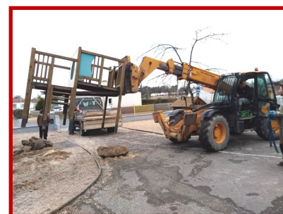
Les grands moyens sont employés pour retirer l'ancienne structure.
